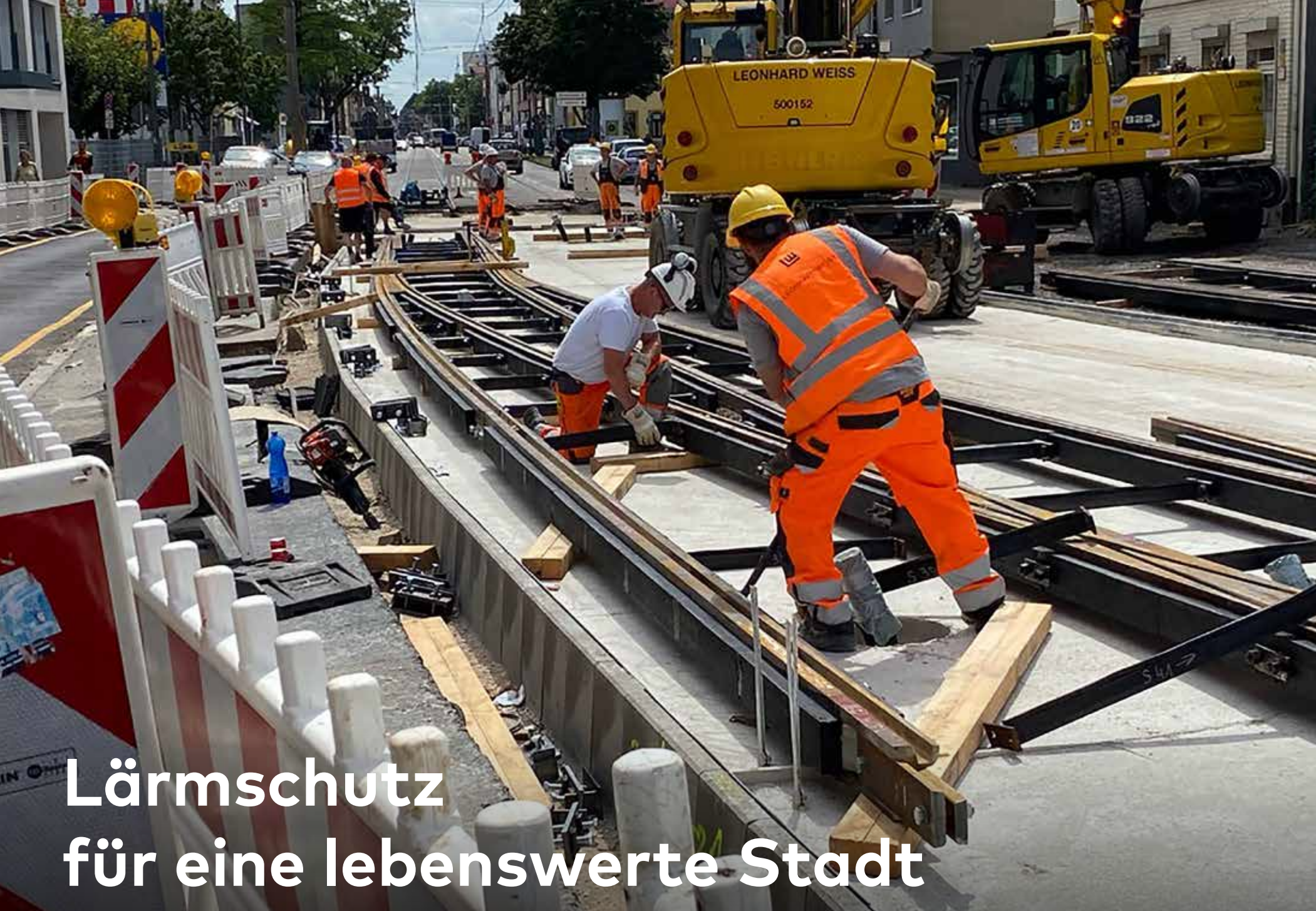
Einbau des Masse-Feder Systems zur Geräuschreduzierung
