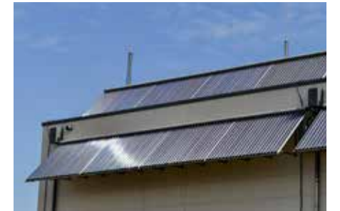
Solarthermie-Anlage
