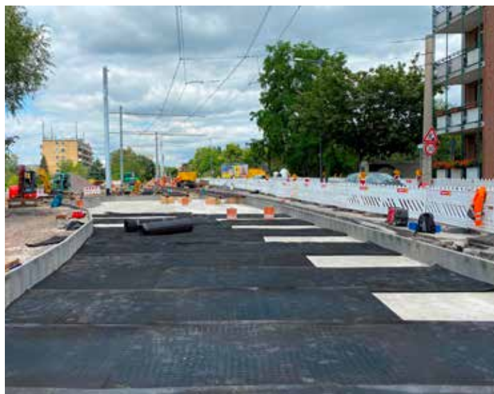
Einbau des Masse-Feder Systems zur Geräuschreduzierung
