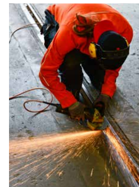
Regelmäßiges Schleifen der Schienen reduziert Radgeräusche
