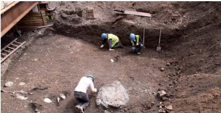
Da die Verteilerebene größer ist als die Baugrube, wird zurzeit unter archäologischer Begleitung neben dem Schlitzwandkasten Erde ausgehoben. Sobald rund neun Meter Tiefe erreicht sind, wird der obere Teil der angrenzenden Baugrubenwand abgebrochen, um eine Verbindung zwischen der Hauptbaugrube und der Baugrube für die Verteilerebene herzustellen.
