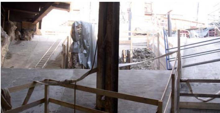
Bei den archäologischen Grabungen wurde im Bereich des Ausgangs zwischen Augustiner- und Pipinstraße ein Teil der Stützmauer der römischen Bebauung gefunden. Der Fund soll an seinem Standort verbleiben und beim Bau der Treppenanlage in das Bauwerk integriert werden. Der Unterbeton der Treppe wurde bereits eingebracht.
