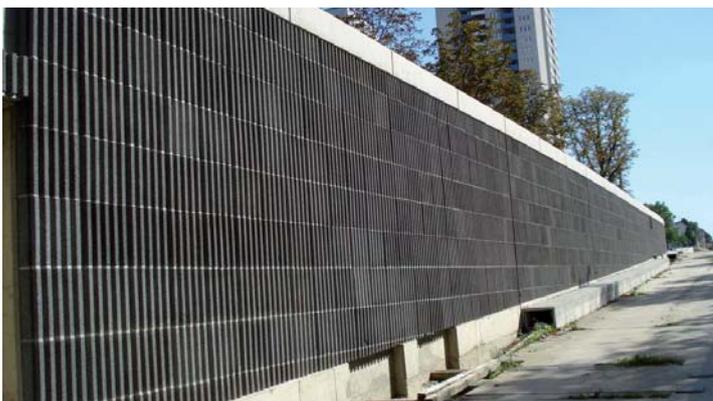
Über eine Rampe kommt die Bahn vom Bonner Wall an die Oberfläche. Hier wurden Lärmschutzelemente installiert, die den Schall bei Betrieb der Stadtbahn brechen und so die Geräuschentwicklung minimieren.
