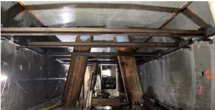
Der Rohbau der Haltestelle entsteht zum einen innerhalb der beiden Baugruben, zum anderen auch in der Verbindung der Gruben unterhalb des Perlengrabens. Sohle und Decke dieses unterirdischen Durchgangs wurden aus Stahlbeton gefertigt. Innerhalb des Bauwerks befinden sich mächtige Stützen zur zusätzlichen Stabilisierung.
