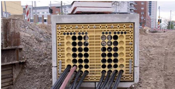
Über dem Tunnel Richtung Haltestelle Marktstraße werden Leitungen verlegt. Unter anderem wird hier ein Kabelschacht der Deutschen Telekom installiert.
