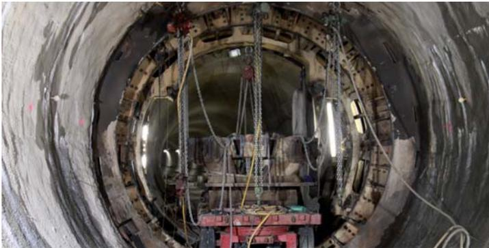
Das Zentrum des Schneidrades aus der Weströhre wird für die Bergung vorbereitet. Diese erfolgt in der Nacht vom 28. auf den 29. April. Beide Schneirad-Zentren werden zur Wiederverwertung zum Hersteller zurückgebracht.
