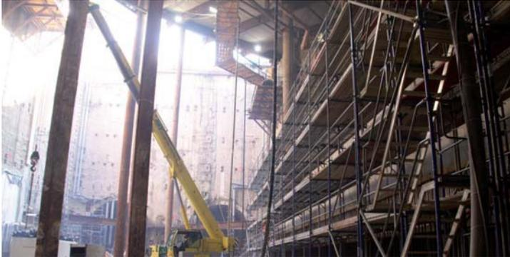
Nachdem die Sohle des Bauwerks betoniert wurde, können nun die Wände der Nord-Süd-Ebene gebaut werden. Derzeit finden Bewehrungs- und Schalarbeiten statt.
