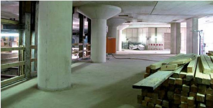
Die große Verteilerebene unterhalb des Kreisverkehrs ist bereits seit 2007 im Rohbau fertig. Der Bereich zwischen der Bauwerksdecke und der Straßenoberfläche wurde mit Erdreich aufgefüllt. Darüber konnte der Kreisverkehr zwischen Chlodwigplatz und Bonner Straße mitsamt den angrenzenden Gehwegen neu gebaut und in den Endzustand versetzt werden.
