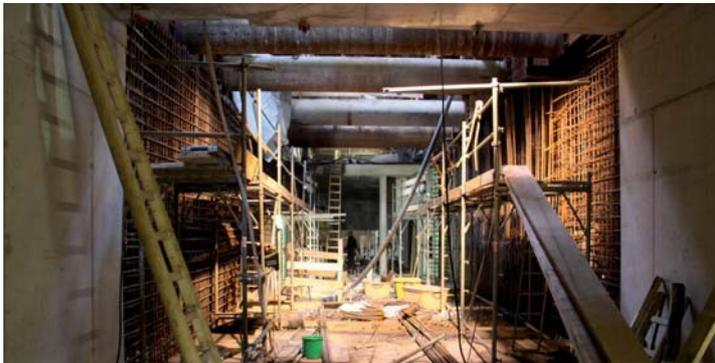
Sohle, Wände und Decke der Bahnsteigebene sind komplett fertig gestellt. Darüber entstehen zwei Stockwerke für Betriebsräume und die Verteilerebene. Auf allen drei Ebenen wird gearbeitet, einige Abschnitte wurden bereits fertiggestellt.
