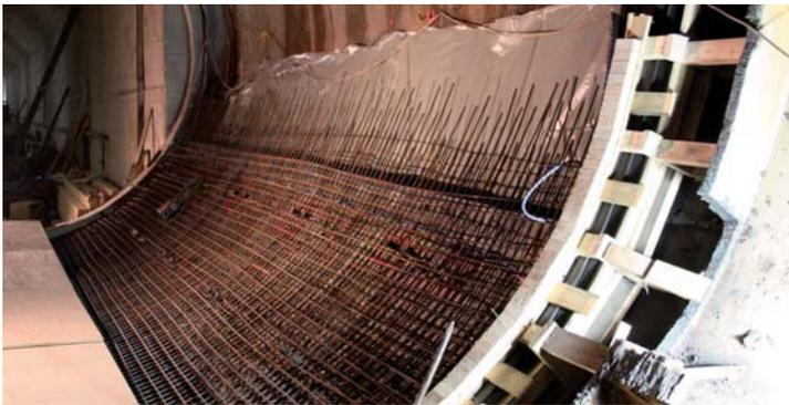
Der Übergang zwischen den Röhren der Tunnelbohrmaschine „Carmen“ und den unter Druckluft gebauten Tunnelabschnitten wird mit Stahlbeton ausgekleidet. Hier finden zurzeit Bewehrungs- und Schalarbeiten statt.
