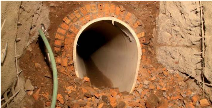
An der Ecke Bonner Straße/ Alteburger Wall wird ein Stollen gebaut, in dem anschließend ein Kanal aus Beton hergestellt wird. Der Kanal wird auf einer Länge von 50 Metern erstellt. Er ist rund zwei Meter hoch und 1,40 Meter breit. Durch ihn wird das Kühlwasser eines nahe gelegenen Heizkraftwerks transportiert.
