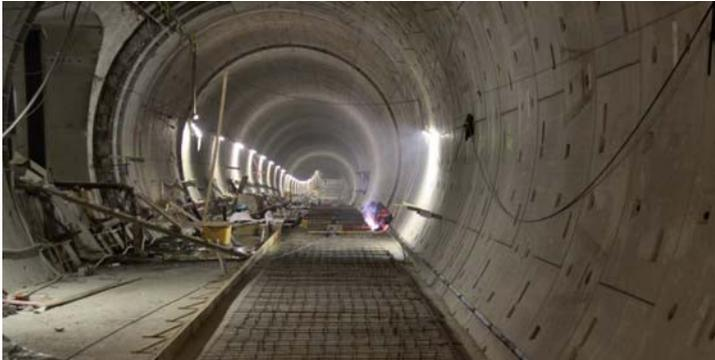
Innerhalb der Röhren werden sogenannte Gleistragplatten betoniert. Diese bestehen aus einer rund 1,40 Meter mächtigen Betonschicht, auf die eine 15 Zentimeter dicke „bewehrungsarme Zone“ aufgebracht wird. Eine in der üblichen Art und Weise bewehrte Schicht würde das spätere Befestigen der Gleise erschweren.
