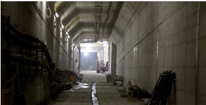
Vom Kurt-Hackenberg-Platz aus wurden unter dem Museumskomplex mithilfe eines Druckluftverfahrens Teilstücke der Nord-Süd Stadtbahn-Tunnel gebaut (nähere Informationen siehe Publikation „Tunnelbau unter Druckluft“). Sie schließen an die Röhren an, die die Schildmaschine „Carmen“ gebaut hat, und sind seit Februar 2009 fertig.
