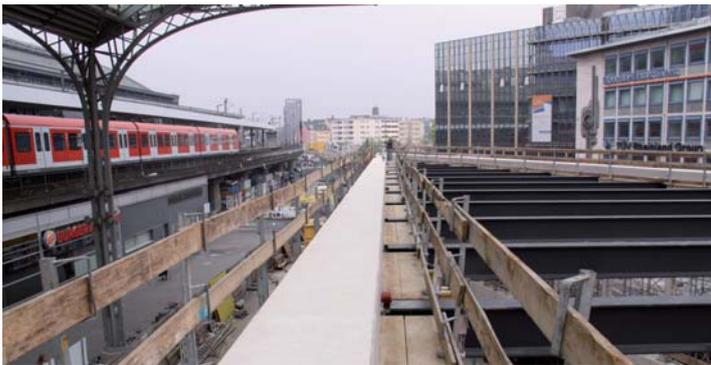
Über die Ausgänge „Breslauer Platz“, „Eigelstein“ und „Kunibertsviertel“ gelangen die Fahrgäste an die Straßenoberfläche. Hier wurden bereits Stützen aus Stahlbeton gebaut, die später die Dächer der Ausgänge tragen sollen. Zurzeit werden die Stützen oben miteinander verbunden. Hierfür werden durchgängige Balken betonierte.
