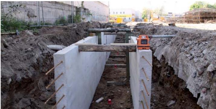
In dem Bereich, in dem der Tunnel und der Trog für die Verbindungsstrecke zwischen Bonner Wall und Rheinufer entstehen, müssen zunächst „Schlitzwände“ erstellt werden. Für den Einsatz des hierfür benötigten Spezialbaggers werden zuerst sogenannte Leitwände gebaut, die helfen, den Greifer des Baggers gerade in die Tiefe zu führen.
