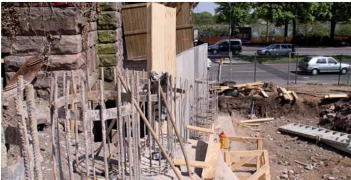
Zur Sicherung des Bahndamms wird eine Bohrpfehlwand gebaut. Hierzu wurden Stahlbeton-Pfähle in einer Reihe nebeneinander überschritten angeordnet und in den Boden eingebracht. Der obere Bereich der Säulen wird nun für den Bau eines verbindenden Kopfbalkens vorbereitet.
