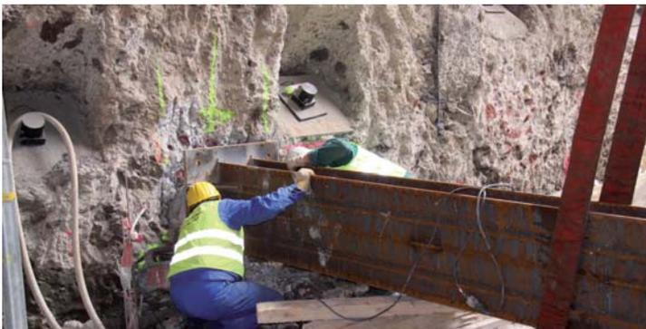
Die Baugrube für den Anschluss an die Haltestelle Dom/ Hbf. wird mit Stahlaussteifungen gesichert. Die Arbeiten werden weitergeführt, wenn die Vereisung in der Bechergasse abgeschlossen ist, da erst dann eine Grundwasserhaltung in Betrieb genommen werden kann.
