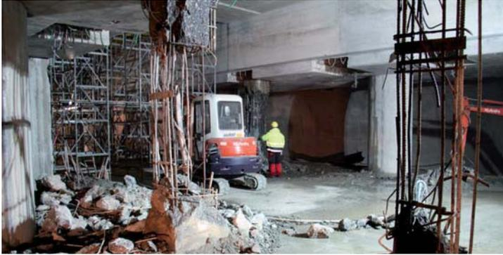
Zwischen Sohle und Decke der Bahnsteigebene wurden Stahlbetonstützen aus Sichtbeton gebaut. Die hier zuvor genutzten temporären Stützen können nun abgebrochen werden.
