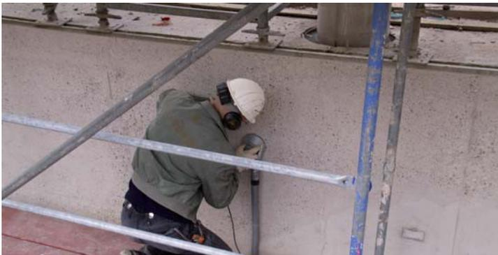
Die Wände der Haltestelle bestehen aus Sichtbeton. Zur Verbesserung der Optik finden derzeit umfangreiche Betonschleifarbeiten statt. Die Wände müssen im Rahmen des späteren Ausbaus nicht mehr verkleidet werden.
