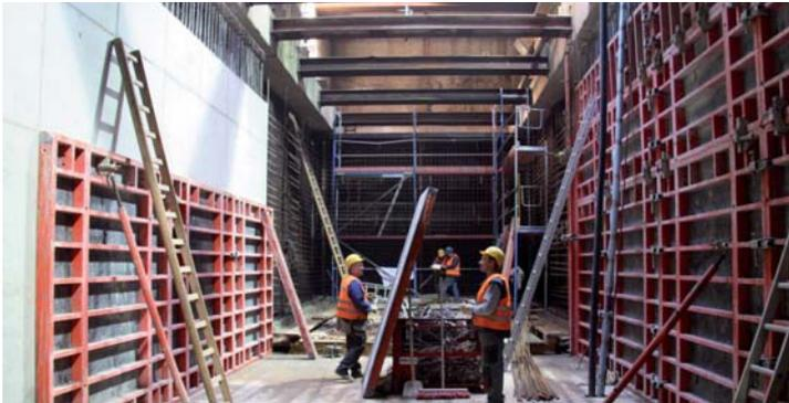
In der nördlichen Hälfte der Nordbaugrube und der südlichen Hälfte der Südbaugrube sind die Sohlen fertig und der Rohbau wird an den Wänden weitergeführt. Die anderen Abschnitte der Gruben werden zurzeit noch zur Andienung der Vortriebsarbeiten unterhalb des Perlengrabens benötigt. Sind diese abgeschlossen, wird auch hier der Rohbau erstellt.
