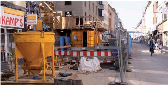
Nachdem der Rohbau schon weit fortgeschritten ist, wird nun die Straße erneuert. Unter anderem werden die Stahlbetonplatten, über die zurzeit der Verkehr fließt, abgebaut. Leitungen werden verlegt und der Raum zwischen Bauwerksdecke und Straße wird mit Sand und Kies verfüllt. Begonnen wurde mit dem Straßenbau am 14. April, bis Ende des Jahres werden die Arbeiten abgeschlossen sein.
