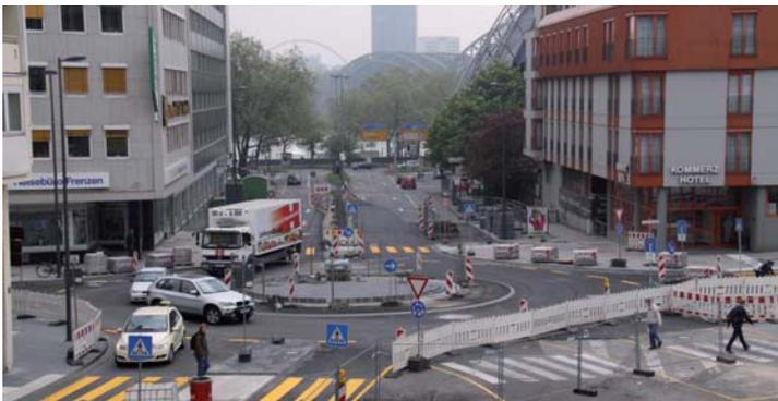
Die Straßenoberfläche wird im Nahbereich des Breslauer Platzes erneuert. Zurzeit finden vor allem Arbeiten auf der Maximinenstraße statt. Der endgültige Kreisverkehr ist nun nutzbar, lediglich die oberste Deckschicht fehlt noch und wird zu einem späteren Zeitpunkt aufgebracht. Der während der Bauzeit genutzte provisorische Kreisverkehr wurde zurückgebaut.
