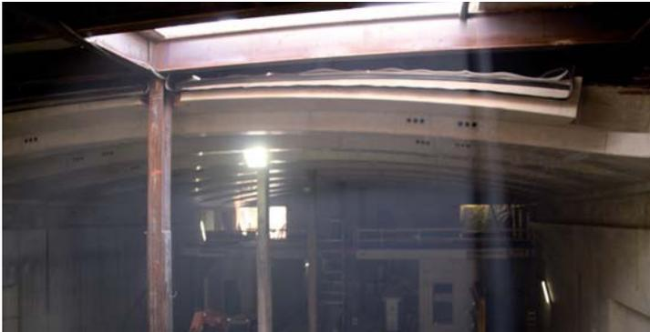
Die Gewölbedecke des Bauwerks wird in mehreren Abschnitten hergestellt. Der First befindet sich nur knapp unterhalb der Straßenoberfläche. Um genügend Platz zum Arbeiten zu haben, muss daher im jeweiligen Baubereich die sich darüber befindende Abdeckung der Straße geöffnet werden.
