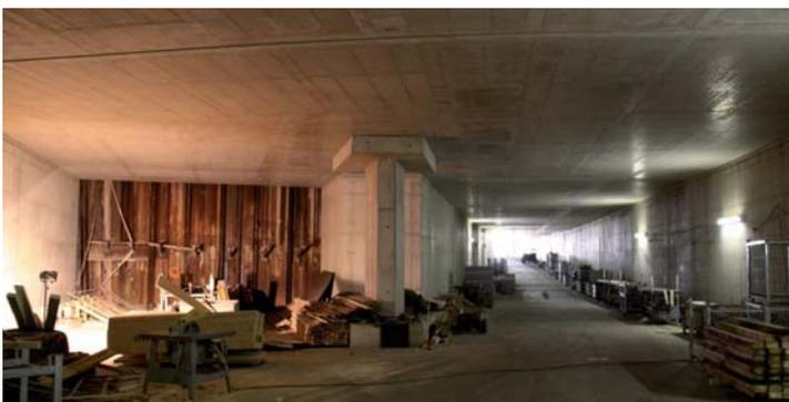
Stadtbahnen können später vom Bonner Wall in südliche Richtung zu den Haltestellen Marktstraße und Schönhauser Straße weiterfahren. Tunnel und Rampe in Richtung Marktstraße (rechts) sind bereits fertig. Hinter einer hochwassersicheren Schottwand (links) entsteht zurzeit der Anschluss Richtung Schönhauser Straße.
