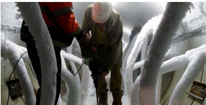
Der Verbindungsstollen zwischen Nord- und Südbaugrube wurde mit Spritzbeton gesichert. In den kommenden Monaten werden von hier aus noch Verbindungen zu den außerhalb der Haltestelle verlaufenden Tunnelröhren geschaffen. Die Arbeiten finden unter Vereisung des Grundwassers statt. Durch die „Eiswände“ wird das Wasser aus dem Baubereich ferngehalten.
