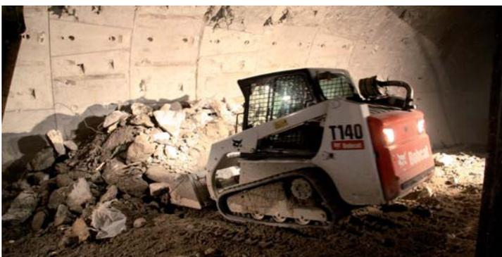
Aus der Baugrube heraus wurden Durchgänge zu den außerhalb der späteren Haltestelle gelegenen Tunneln aufgebrochen und befestigt. Um die Tunnel während des Baus der sogenannten Querschläge zusätzlich zu stabilisieren, wurde eine Betonsicherung vorgenommen. Diese konnte bereits wieder abgebrochen werden, der hierbei entstandene Schutt wird derzeit gefördert und abtransportiert.
