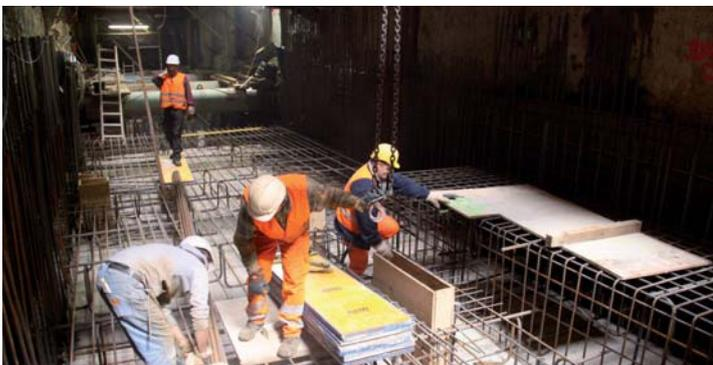
Die Sohle der Bahnsteigebene wird in fünf Abschnitten hergestellt. Diese werden nacheinander bewehrt, geschalt und betoniert. Derzeit sind zwei Abschnitte fertig gestellt. Über der Bahnsteigebene werden im Zuge der Rohbauarbeiten ein weiteres Geschoss mit Betriebsräumen und darüber die Verteilerebene entstehen.
