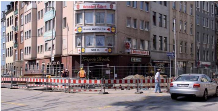
Für den Bau des Ausgangs Bonner Straße Ecke Bonner Wall wurde ein neues kleines Baufeld eingerichtet. Hier finden erste Aushubarbeiten statt. In diesem Zuge werden die im Bau Feld vorhandenen Leitungen umverlegt.
