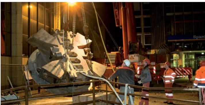
Als die Tunnelbohrmaschine „Carmen“ ihre Röhren fertig gebohrt hatte, mussten die Schneidräder am Ende des Tunnels in der Erde bleiben. Nach Abschluss des Druckluftvortriebs und Fertigstellung der rund 100 Meter langen Verbindungstunnel unter dem Museumskomplex können die Schneidräder demontiert werden. Das in mehrere Einzelteile zerlegte Schneidrad aus dem östlichen Tunnel wurde bereits geborgen.
