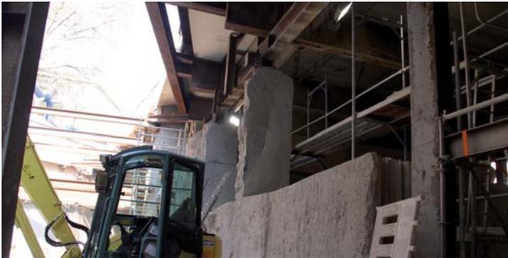
Die Verteilerebene, von der aus man zur oberirdischen Haltestelle Heumarkt gelangt, wird teilweise außerhalb der Baugrubenumschließung gebaut. Daher müssen Teile der Wand, die die Baugrube umschließt, bis in eine Tiefe von 6,50 Metern abgebrochen werden.
