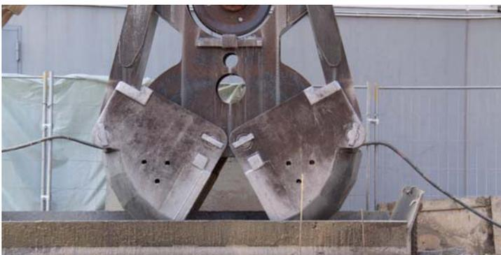
Ein Schlitzwandbagger hebt Gräben aus, die zunächst mit einer Stützflüssigkeit gefüllt werden, damit keine Erde hineinfällt. Ist die Endtiefe erreicht, werden Bewehrungskörbe aus Stahl eingelassen. Danach wird Beton in die Gräben eingefüllt und die nicht mehr benötigte Stützflüssigkeit kann zeitgleich abgepumpt werden.
