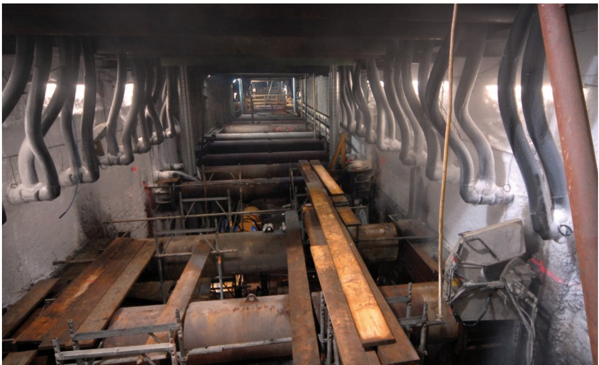
In der Baugrube verästelte sich das Leitungssystem nahe den Baugrubenwänden.
