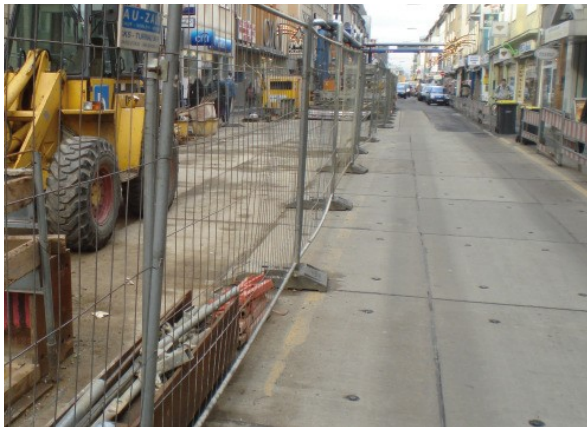
Die Abdeckung der Baugrube.
