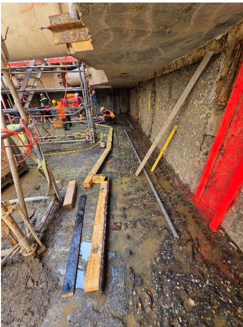
Blick in die Baugrube des Gleiswechsels Waidmarkt: Ende der vergangenen Woche konnte nun bereits der erste Teil der Decke im südlichen Bereich (Richtung Severinstraße) abgebrochen werden.
