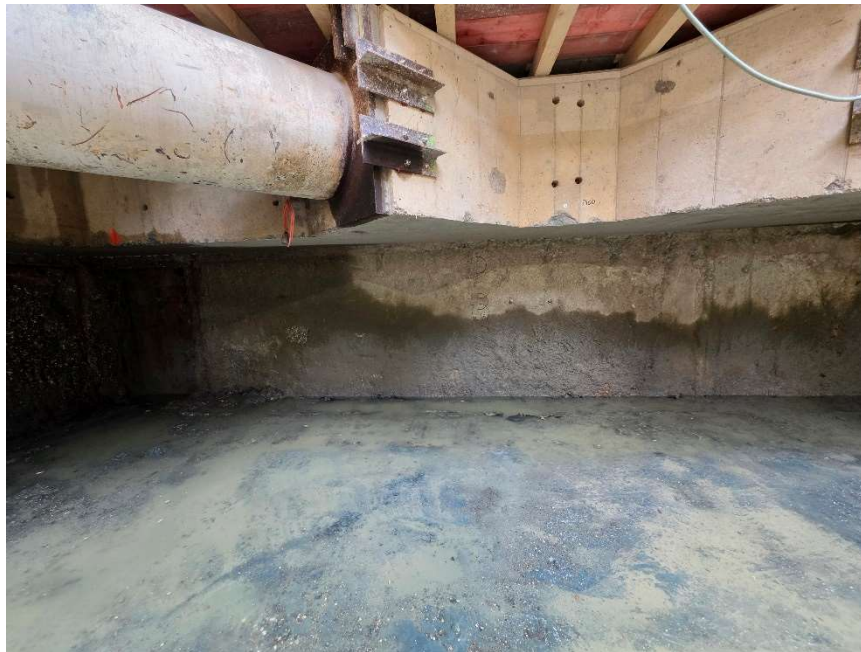
Blick in die Baugrube des Gleiswechsels Waidmarkt: Ende der vergangenen Woche konnte nun bereits der erste Teil der Decke im südlichen Bereich (Richtung Severinstraße) abgebrochen werden.
