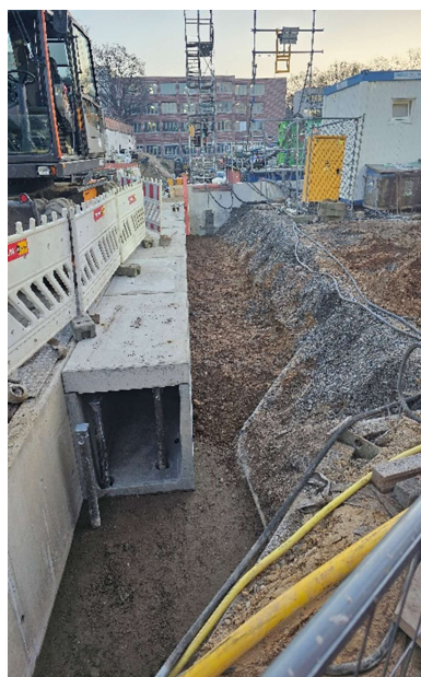
Frisch betonierte Bodenplatte für den Aufbau einer Vereisungsanlage im Bereich des östlichen Baufeldes (Bild oben links).
