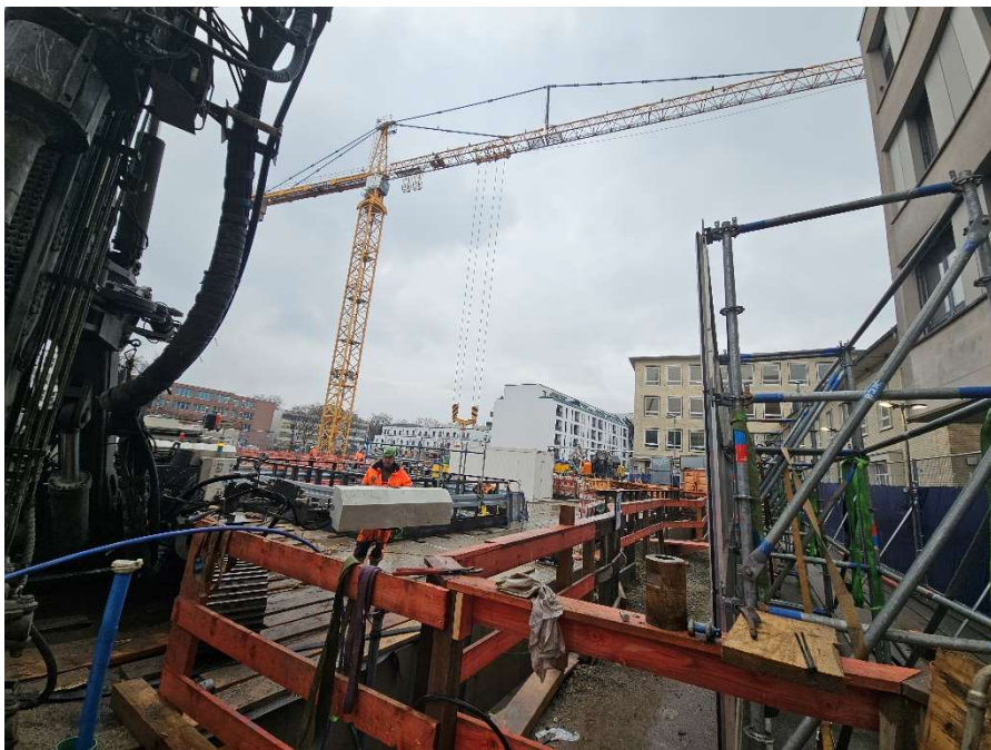
Bohrgerät zur Herstellung der Bohrlöcher für die benötigten Vereisungslanzen.
