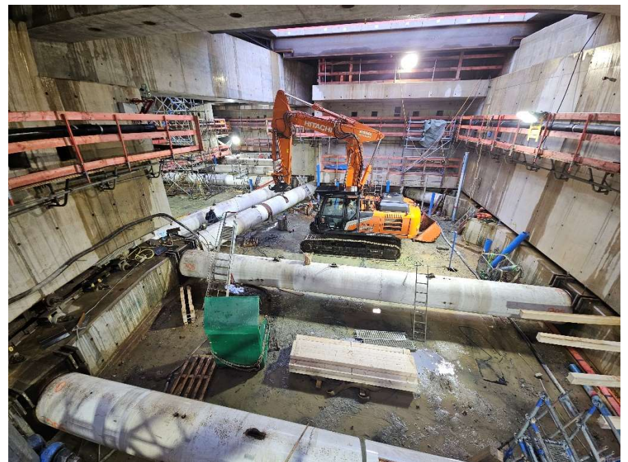
Vormontage für die erste Aussteifungslage in der obersten Bauwerksebene.
