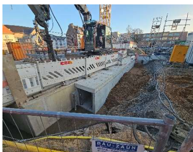
Frisch betonierte Bodenplatte für den Aufbau einer Vereisungsanlage im Bereich des östlichen Baufeldes (Bild oben links).
