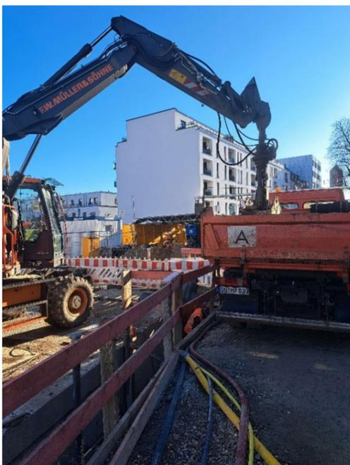
Beginn der Erdarbeiten zum späteren Einbau der Vereisungskanäle.
