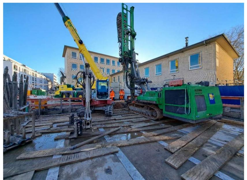
Blick auf die Baugrubenabdeckung über dem Gleiswechselbauwerk: Die Bohrarbeiten für die nachfolgende Vereisung wurden wieder aufgenommen und sind in vollem Gang.
