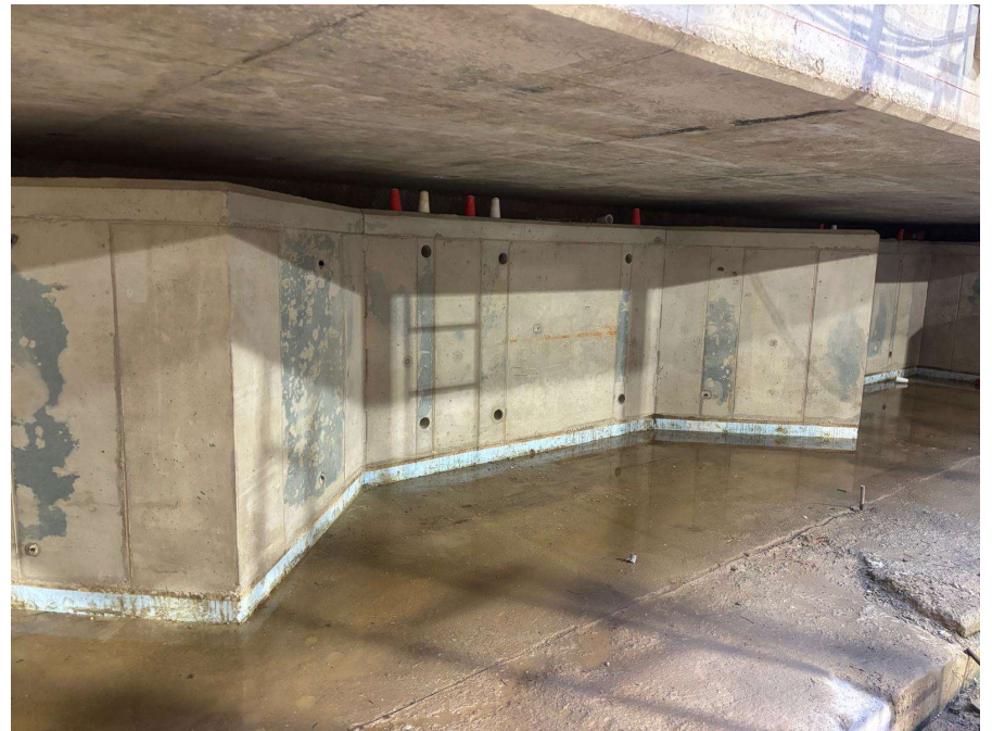
Blick in die oberste Ebene der Baugrube: Der erste Betonbalken zur Aussteifung der Baugrube ist fertig. Die für die Betonage benötigte Schalung wird noch dieses Jahr entfernt.
