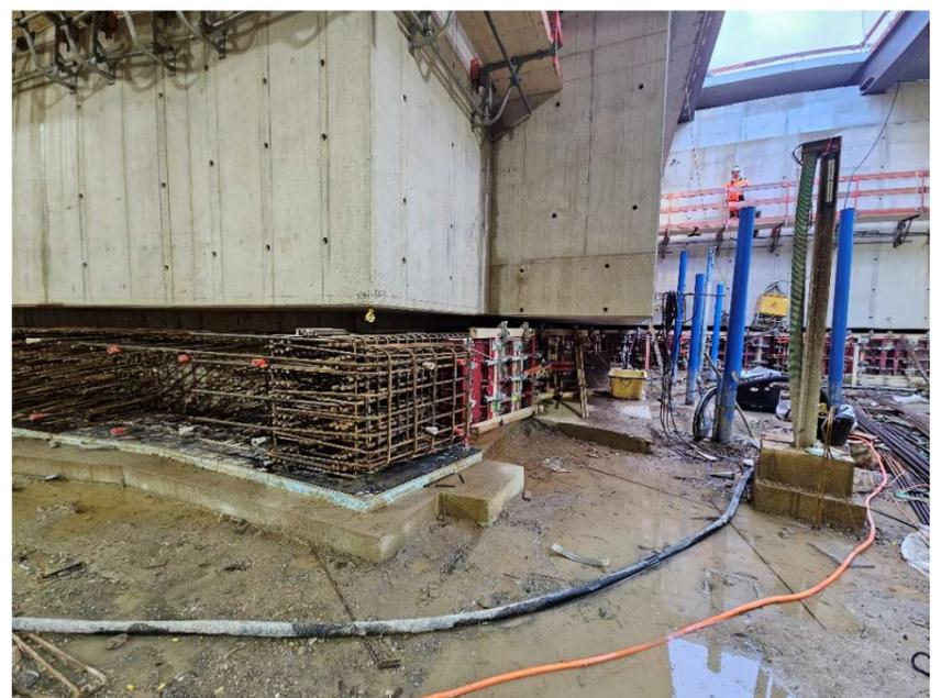
Blick auf die Westseite der Baugrube: Die Fugen werden verschlossen. (Bild links). Sowohl die Bewehrung als auch die Schalung für den massiven Betonbalken unterhalb der Vorsatzschale sind zur Hälfte fertig (Bild rechts). Die Betonage des Balkens erfolgt noch dieses Jahr.
