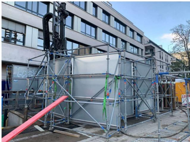
Vergangene Woche haben Bohrungen für das Einbringen von Vereisungslanzen begonnen. Die Arbeiten werden mit zwei Bohrgeräten durchgeführt. Damit die Belastung für die Anwohner möglichst gering ist, werden um die Bohrgeräte mobile Lärmschutzwände gebaut (Foto links). Von den 46 Bohrungen konnten bereits sechs auf eine Endtiefe von ca. 40 Metern gebracht werden.
