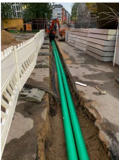
Mit dem Deckel hat sich der Blick auf die Baustelle vollkommen verändert. Die umlaufende Lärmschutzwand wurde durch Bauzäune ersetzt, die nicht mehr ganz so hoch sind und an einigen Stellen den Einblick in das Baufeld ermöglichen. Im nördlichen Baufeld wurde eine Kanaltasse erstellt, die zur Kabelführung für die Stromversorgung dient.
