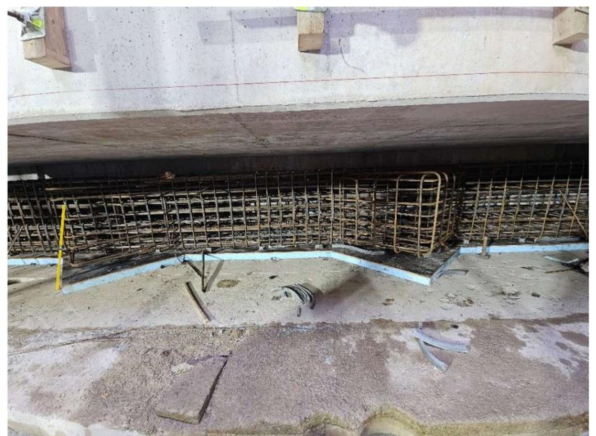
Blick in das Innere der Baugrube: Die Baustelle ist inzwischen komplett mit Betonfertigteilen abgedeckelt (Bild links). Die Bewehrung für einen weiteren, massiven Betonbalken unterhalb der Vorsatzschale, gegen den später eine erste Stahlaussteifung verspannt wird, ist an einigen Stellen bereits fertig (Bild rechts).
