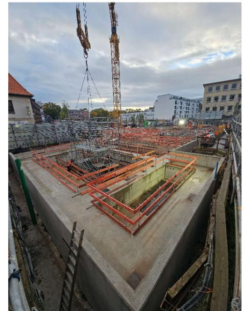
Drei Perspektiven: Der auf den Schlitzwänden aufgelagerte „Kopfbalken“ sowie die umlaufende „Kammerwand“ wurden erfolgreich betoniert und sind inzwischen ausgeschalt.
