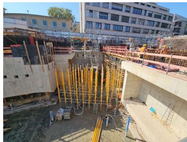
Schalungen für Kopfbalken und Auflager der Baugrubenabdeckung (Foto li.). Montage der Stützen für die Querbalken (Foto re.).
