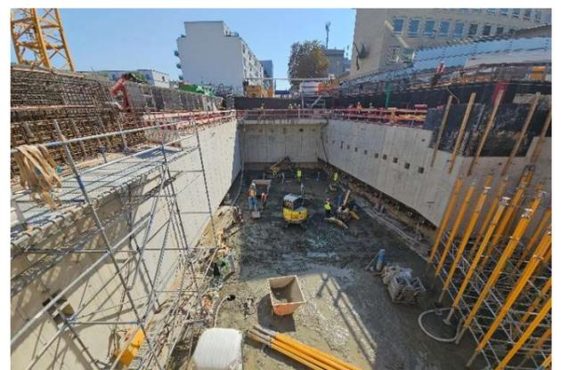
Der Abbruch der oberen Betondecke (Fotos li. und Mitte) ist inzwischen abgeschlossen. Die „Vorsatzschale“ zur Stabilisierung der Baugrubenwände ist ebenfalls fertig (Foto re.).
