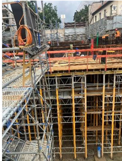
Foto links: Bewehrungsarbeiten für einen neuen Kopfbalken. Foto Mitte: Traggerüste und Schalungen. Foto rechts: Teilabbruch der oberen Decke innerhalb des Gleiswechsels.
