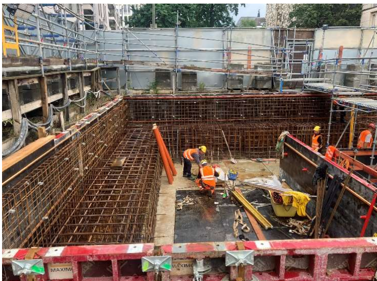
Foto links: Bewehrungsarbeiten für einen neuen Kopfbalken. Foto Mitte: Traggerüste und Schalungen. Foto rechts: Teilabbruch der oberen Decke innerhalb des Gleiswechsels.
