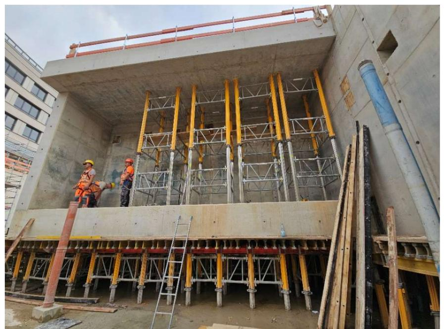
Herstellung einer Vorsatzschale im oberen Bereich der Baugrube. Das linke Foto zeigt eine Wand an der Westseite der Baugrube nahe Rewe, die mit Schalungen für die anschließende Betonage versehen wurde. Rechts ist die bereits fertig betonierte Wand mit Boden- und Deckenplatte vor „Papa Rudi’s“ zu sehen.
