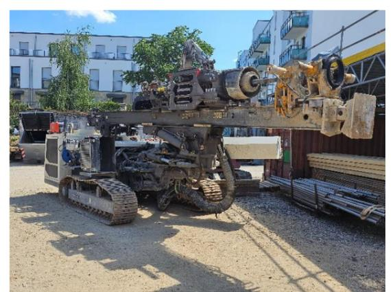
Ausgeschaltete bereits betonierte Wände an der Stirnseite der Baugrube im nördlichen Bereich zwischen Rewe und Papa Rudi's (Fotos links und Mitte). Das rechte Foto zeigt ein neu angeliefertes Bohrgerät, mit dem in den kommenden Wochen Kernbohrungen für später benötigte Brunnen durchgeführt werden.
