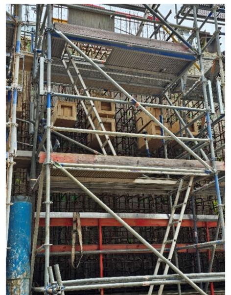
Die sogenannten Sohlscheiben an Wand 1 (Bild links) und Wand 3 (Bild Mitte) sind fertig betoniert. An allen Wänden werden Aussparungen für bestehende Wandverankerungen montiert (Bild rechts).
