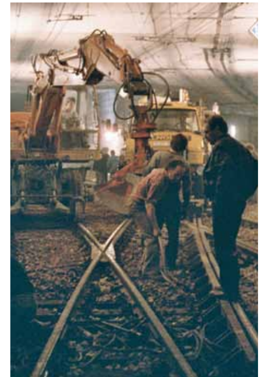
Erneuerungsarbeiten: Gleistausch am Abzweig hinter der U-Bahn-Haltestelle Poststraße, 1984.
