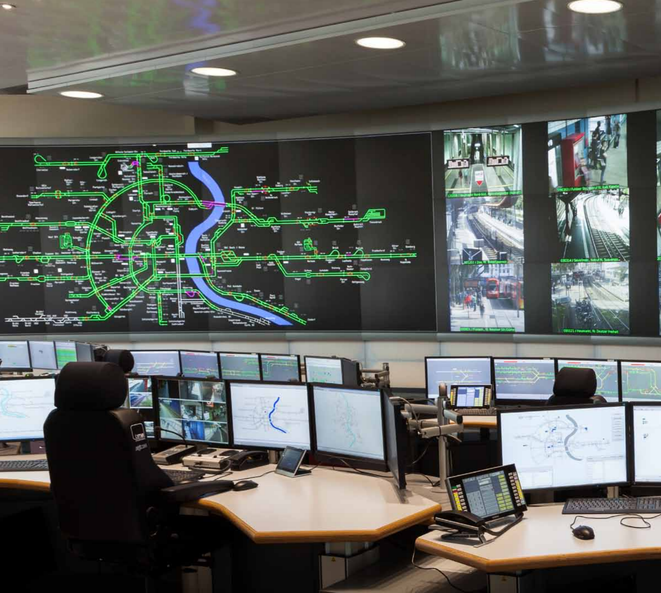
64 Die Monitore der Videowand liefern den Mitarbeitern der Leitstelle jederzeit einen aktuellen Überblick über das Liniennetz, die Stromversorgung und die Situation in den einzelnen Haltestellen.
