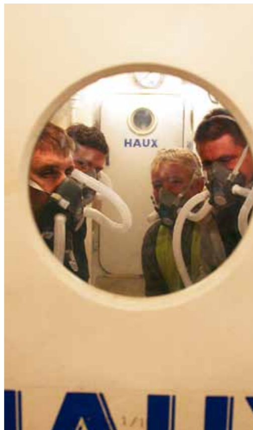
Spezialarbeiter in der Schleuse beim Druckluftvortrieb unterhalb der Kölner Philharmonie.
