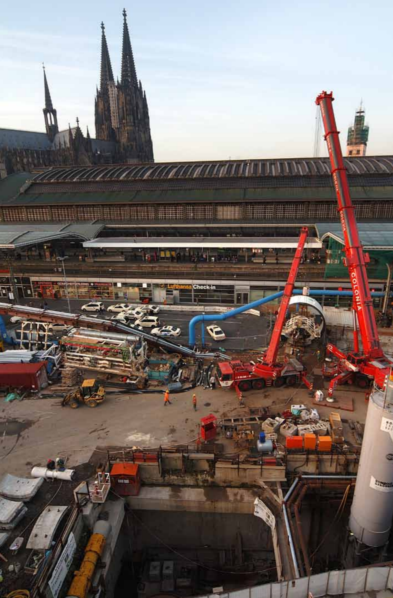
22 Bau der Nord-Süd Stadtbahn: Anfahrtsschacht am Breslauer Platz. Von hier aus wurden die unter dem Kommerzhotel und dem Bahndamm verlaufenden Tunnelröhren bis zur Philharmonie im Schildvortrieb aufgeföhren.
