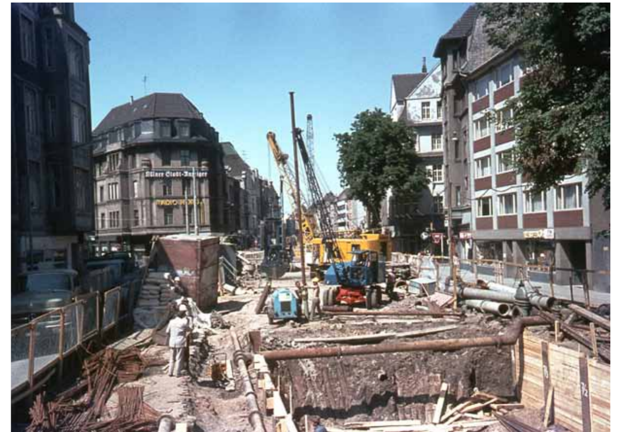
Großflächige Ausschachtungen: U-Bahnbaustelle in Nippes zwischen den Haltestellen Lohsestraße und Florastraße an der Gabelung Neusser Straße/Kempener Straße. Im Sommer 1974 ging die Strecke in Betrieb.
