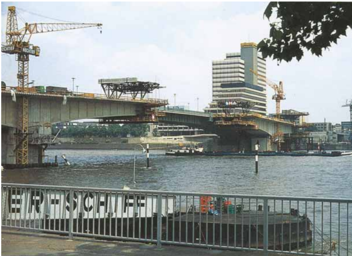
Für den Lückenschluss über die Deutzer Brücke wurde zwischen 1976 und 1980 ein „Brückenzwilling“ gebaut und an die vorhandene Brücke herangeschoben. So ließ sich eine Sperrung während der Bauzeit vermeiden.
