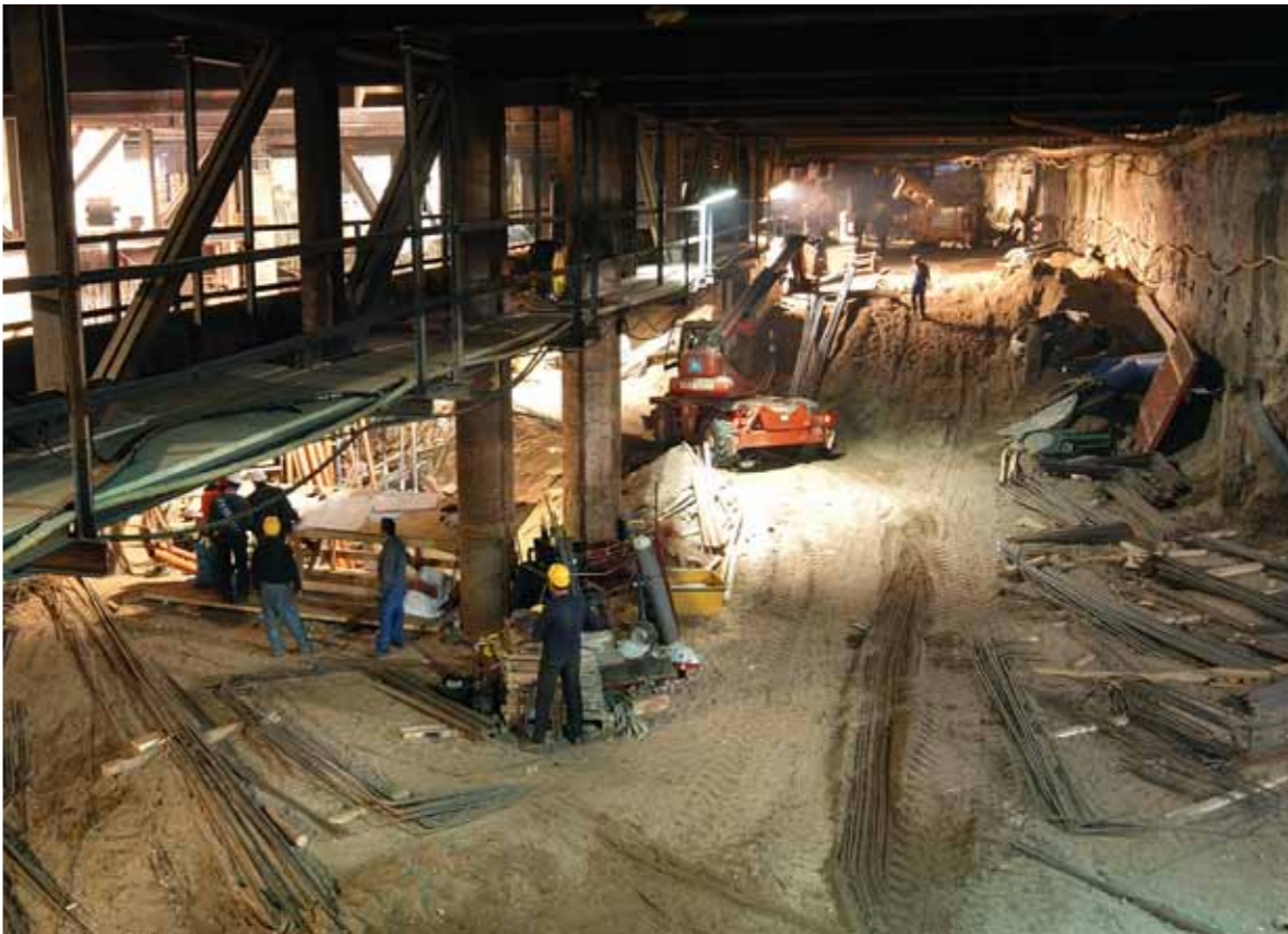
Blick in die Baugrube am Heumarkt: Während in rund 28 Metern Tiefe das größte Bauwerk der Nord-Süd Stadtbahn Köln entsteht, fließt der Verkehr auf der Cäcilienstraße über einen Deckel weiter.
