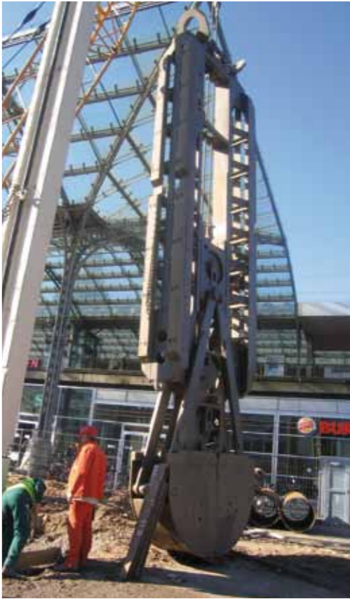
Einsatz eines Schlitzwandbaggers für den Bau der neuen, dreigleisigen Haltestelle Breslauer Platz.
