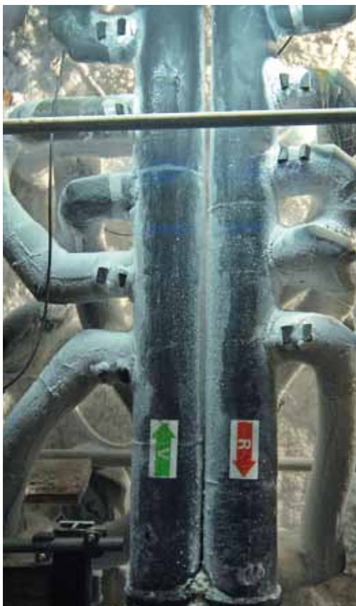
An einigen Bauten der Nord-Süd Stadtbahn wurde Erdreich vereist, um Tunnel und Station zu verbinden.
