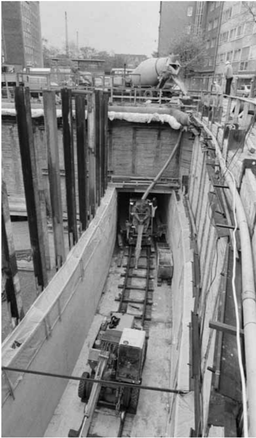
Hans-Böckler Platz 1983: Beton fließt von einem Mischer auf der Straße zu einem zweiten in der Baugrube.
