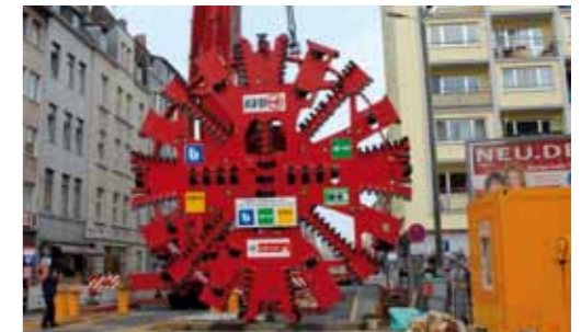
Anlieferung eines Tunnelbohrer-Schneidrads an der Baugrube Bonner Wall, wo es montiert wurde.
