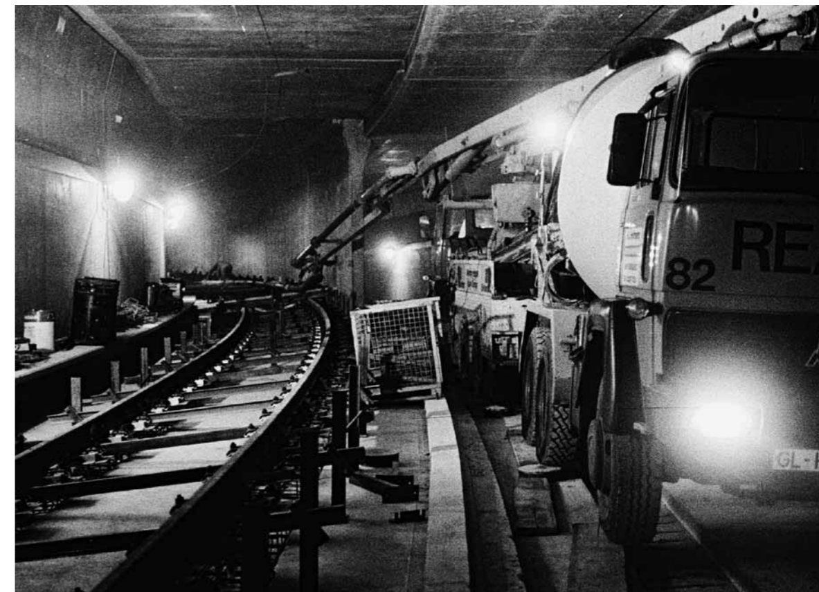
Zwischen 1976 und 1981 wurde der rechtsrheinische U-Bahnabschnitt zwischen Rhein und Vingst fertiggestellt. Hier: Betonarbeiten am Gleis in einer Kurve zwischen Vingst und der U-Bahnhaltestelle Kalk Kapelle, etwa 1978.
