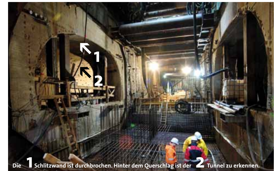
Schalung für den Bau des Querschlags.
