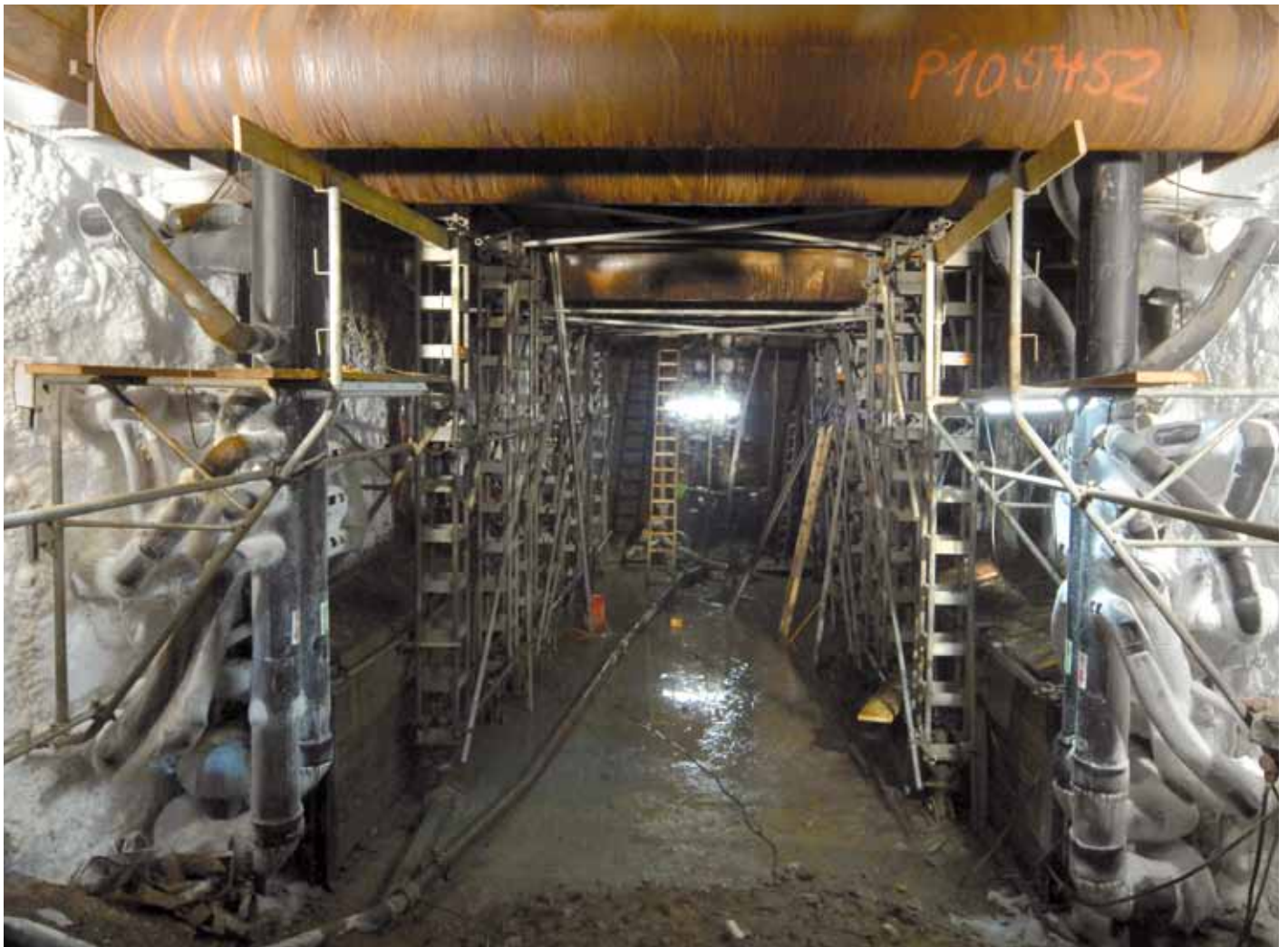
Vereiste Schlitzwände in der Baugrube Kartäuserhof.
