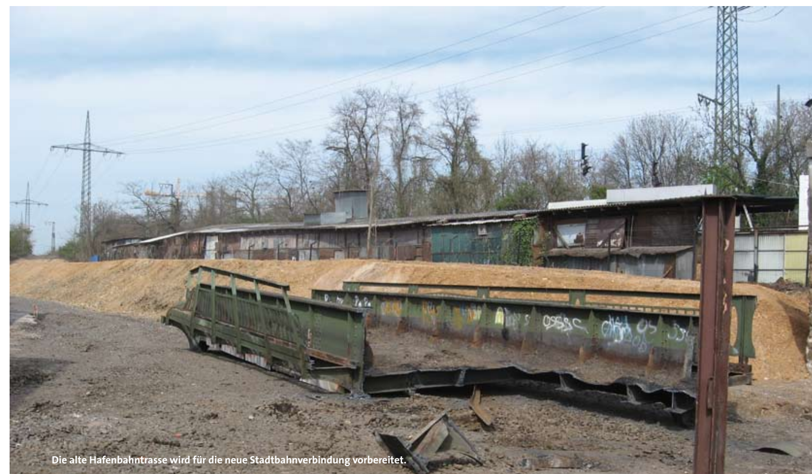
In der Alteburger Straße wird die Eisenbrücke der alten Hafenbahn zurückgebaut.
