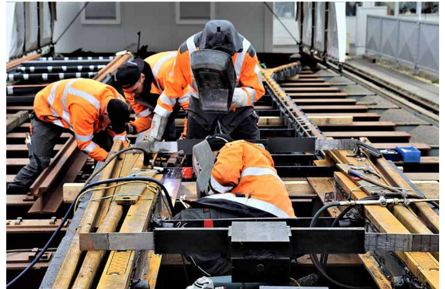
Montagearbeiten an einer Weiche
